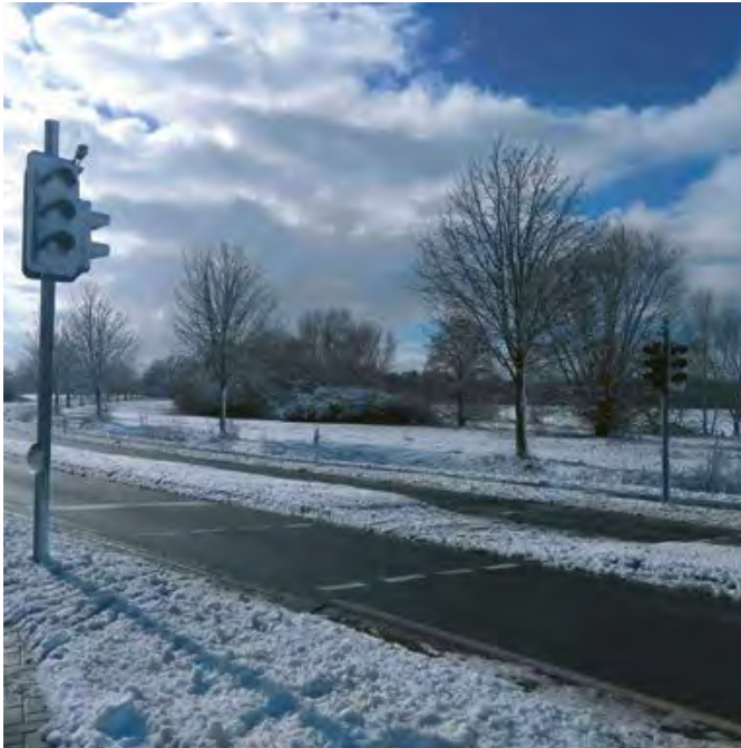
Die Streuscheiben müssen hier im Winter bei Betrieb beheizt werden und ständig für den Kfz-Verkehr auf Grün stehen.
